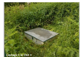
Captage « Le Clôt »
